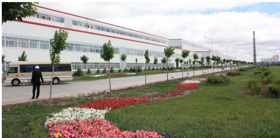
整洁的矿区厂房彰显绿色发展理念 齐殿斌摄
