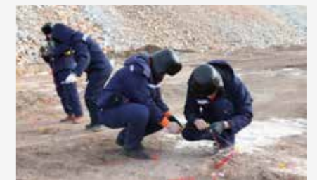
内蒙古矿业公司电子雷管爆破试验
