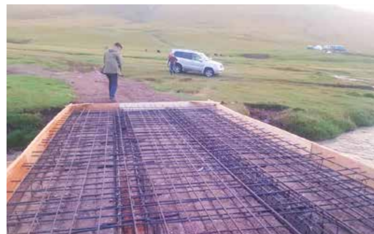
修建中的过水桥梁
