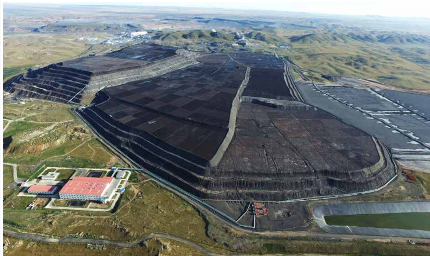
内蒙古太平公司采用埋管滴淋技术的堆浸场
