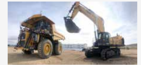
挖掘机和无人驾驶矿卡
