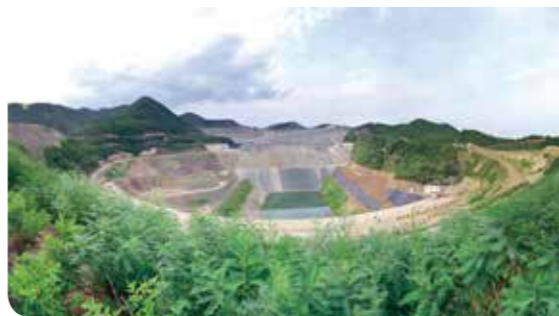
河北东梁公司尾矿库
