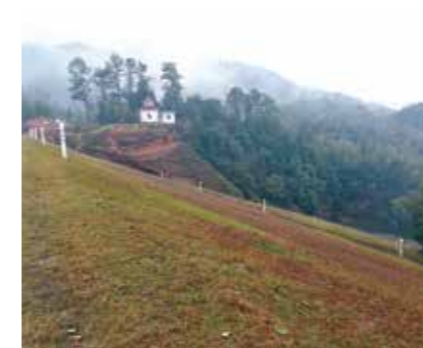
尾矿库安全监测
