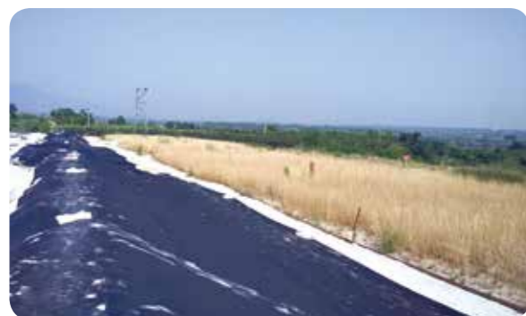
潼关矿业公司为尾矿库覆土，为防止扬尘，进行了盖网保护
