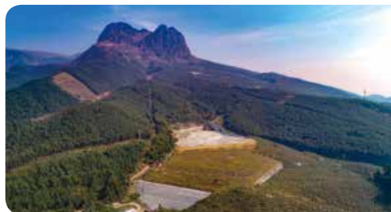
贵港金地公司葛麻冲尾矿库
