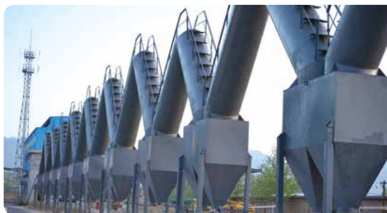
潼关冶炼公司技改项目设施
